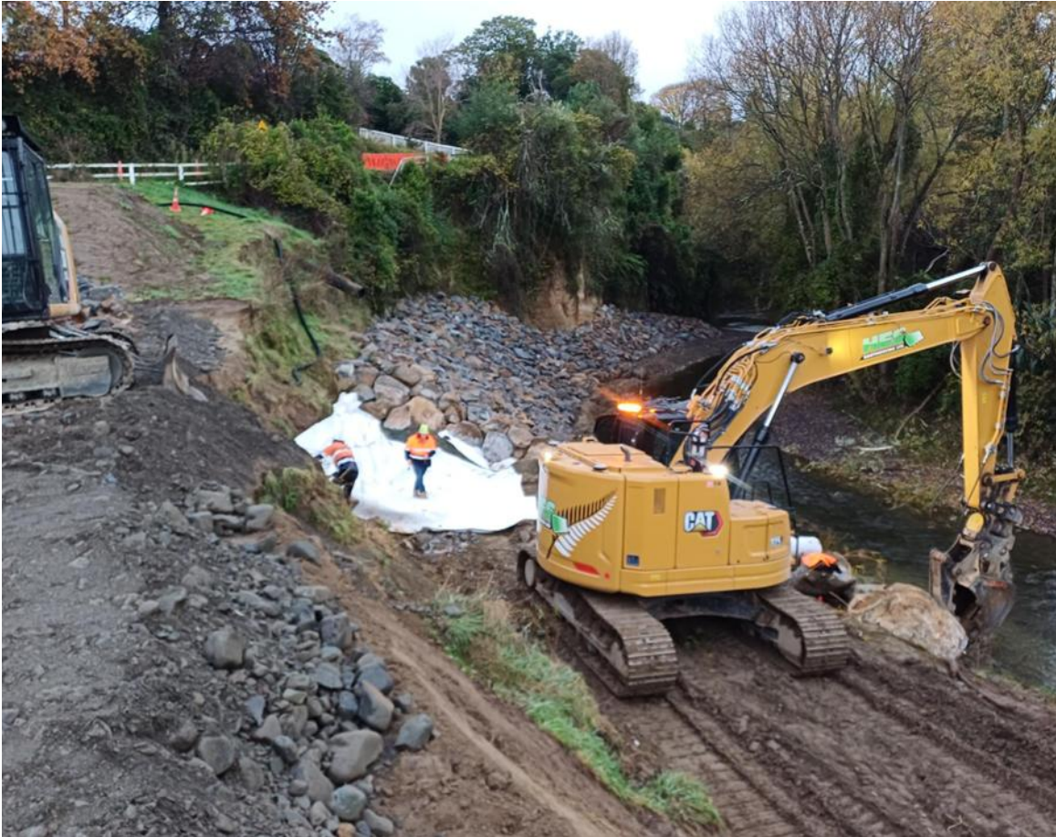
Rock revetment Riverdale Road Dannevirke.
