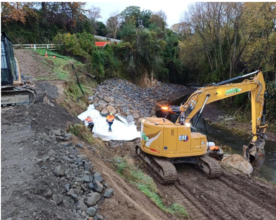
Rock revetment Riverdale Road Dannevirke.
