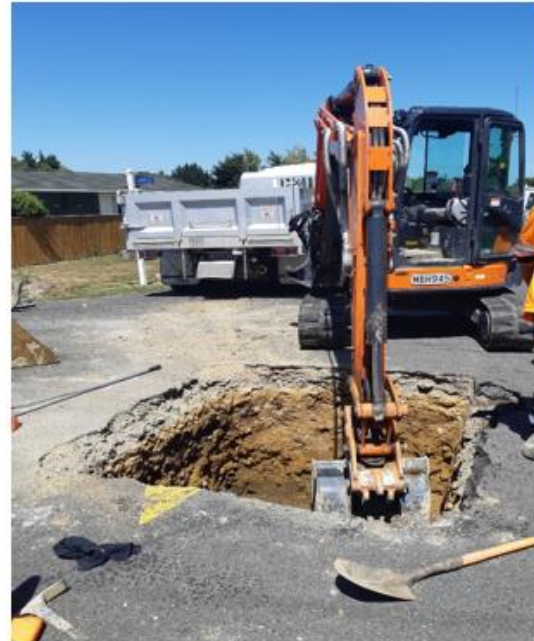
New Manhole install Tiraumea
